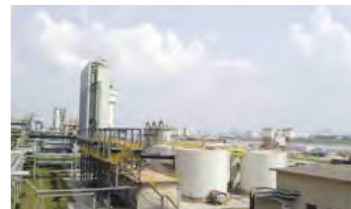
化产系统 Chemical System
